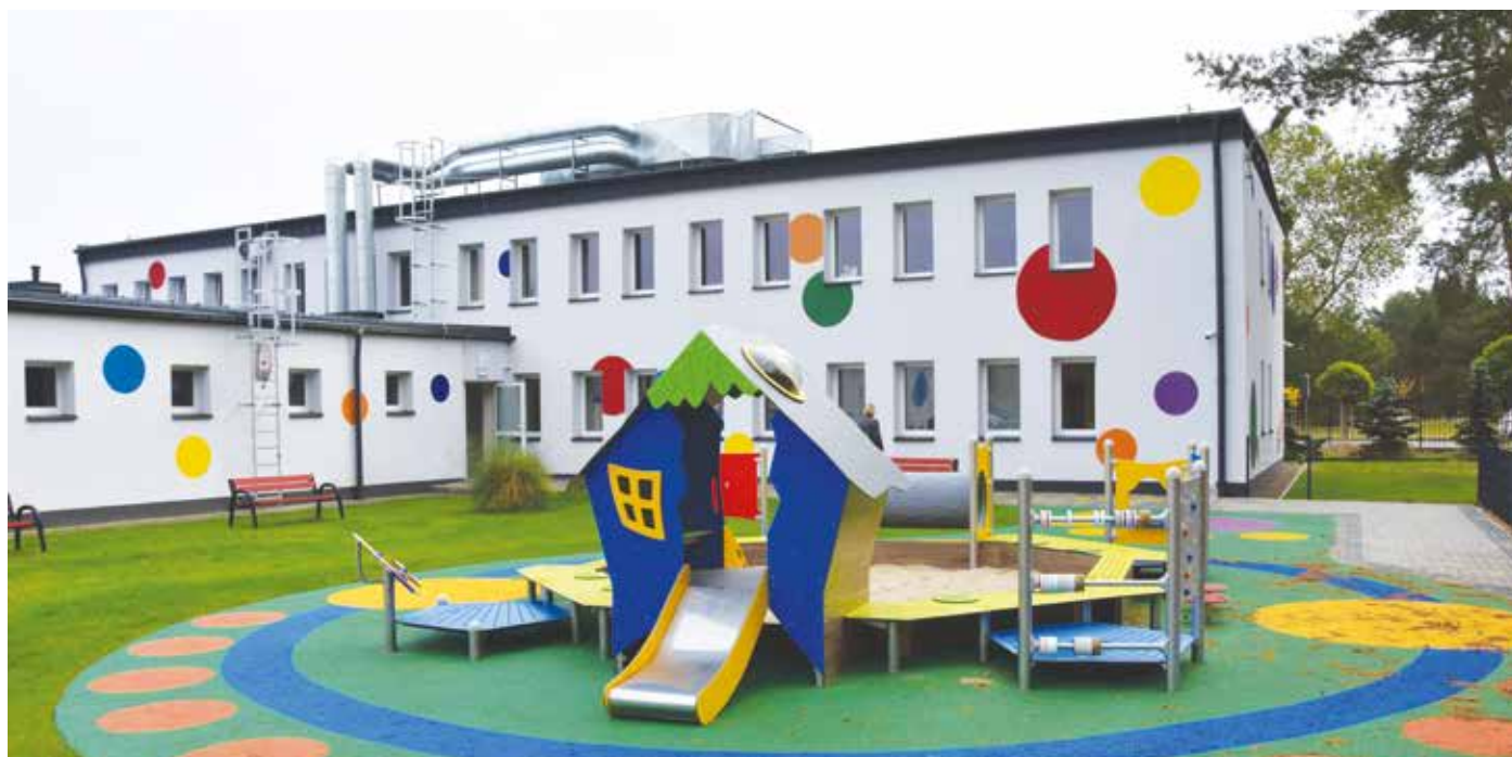
Fot. Modernizacja elewacji Żłobka Miejskiego filia nr 2
