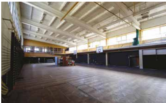
Fot. Hala sportowa przed modernizacją
