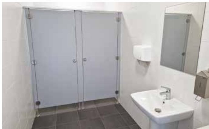
Fot. Łazienka po modernizacji
