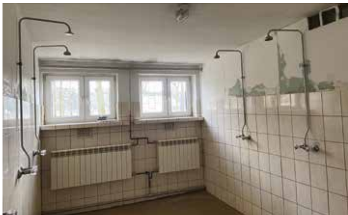
Fot. Łazienka przed modernizacją
