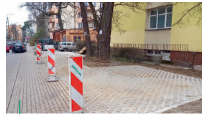
ul. Sosnowa (przy przychodni zdrowia)
