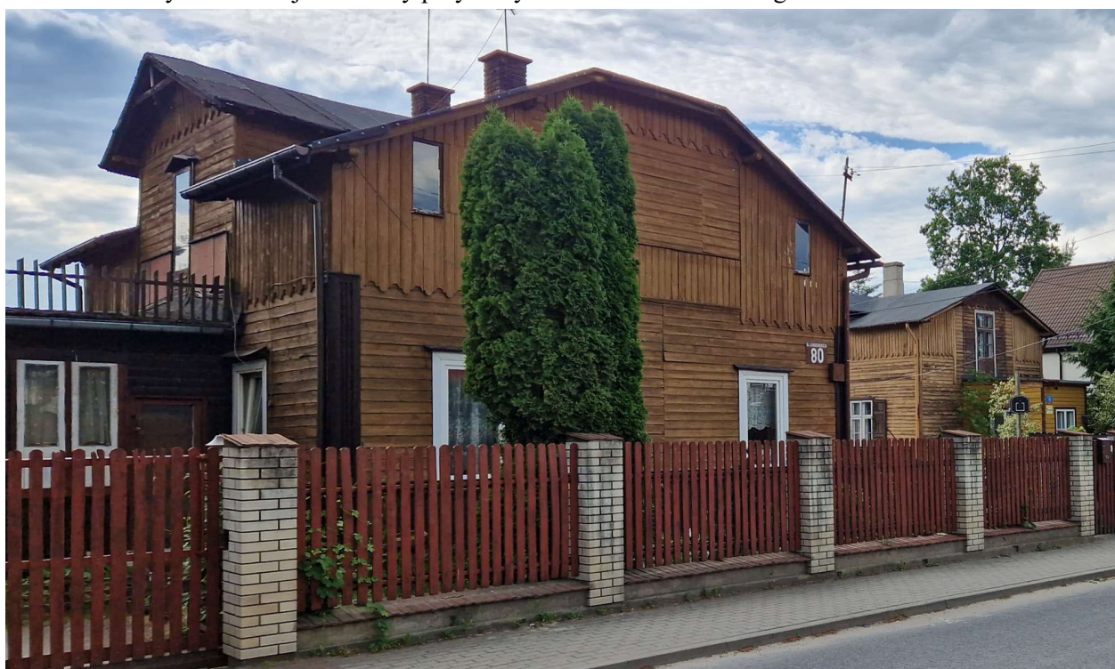
Fot. 12 - Relikty drewnianej zabudowy przy ulicy Waleriana Łukasińskiego
