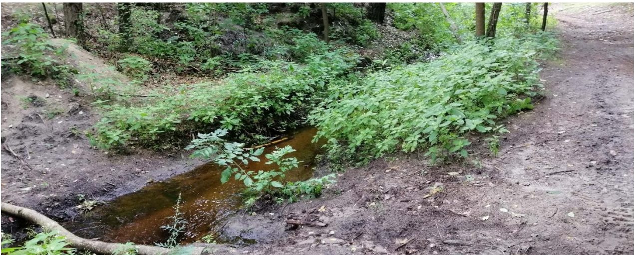
Fot. 5. Rów odprowadzający wodę ze zbiorników wodnych docelowo do Kanału Południowego
