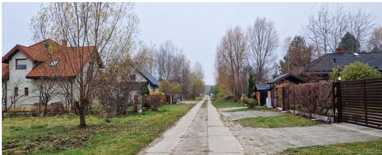
Fot. 6. Nowa zabudowa wzdłuż ulicy Kaczeńców
