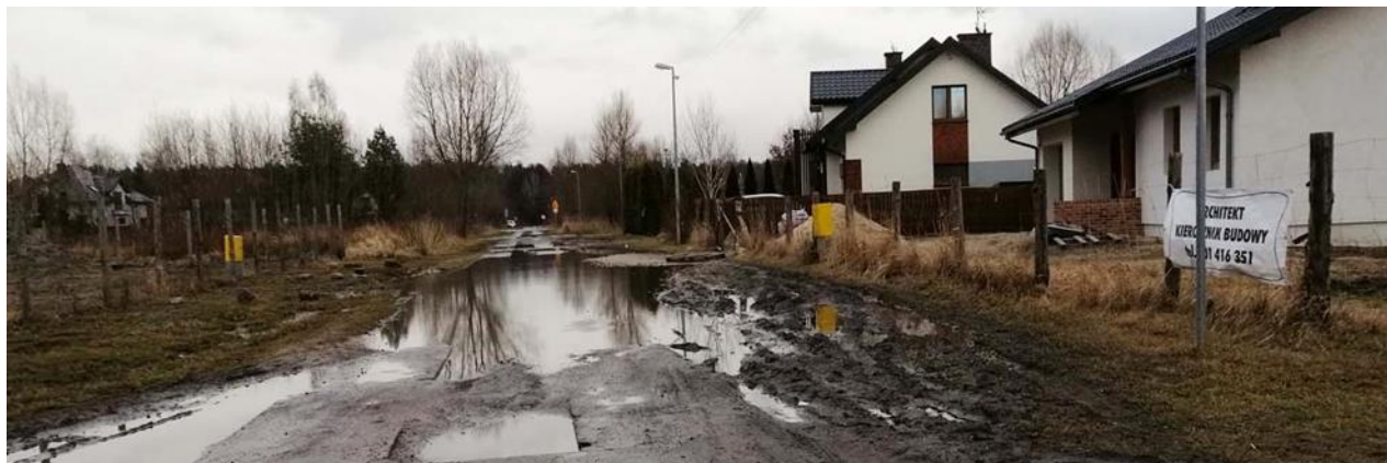
Fot. 3. Nowa zabudowa - Podtopienia
