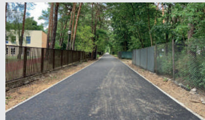
// Ulica Jagiellońska z nawierzchnią asfaltową
