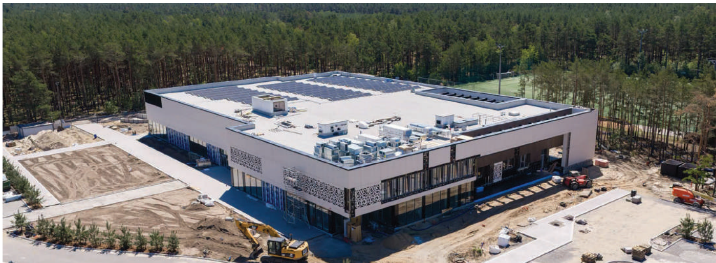
// Budowa kompleksu miejskich basenów przy ul. Karczewskiej - widok z początku czerwca br.
