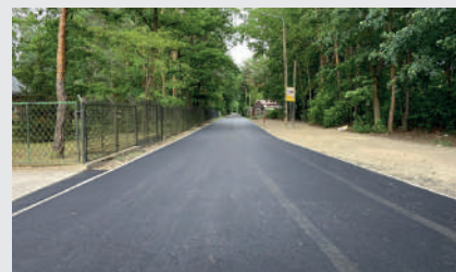
// Asfalt na ul. Kilińskiego
