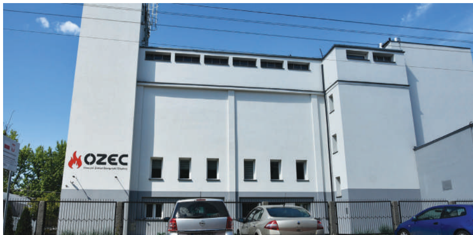
// Siedziba Otwockiego Zakładu Energetyki Ciepłej przy ul. Andriollego.
