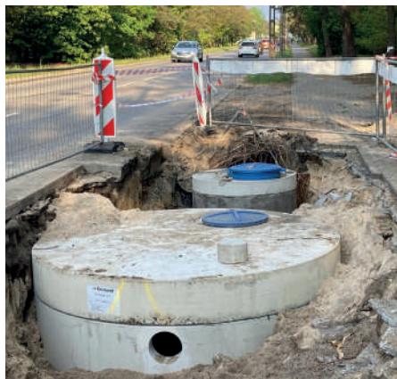
// Nowe odwodnienie na ul. Batorego.
