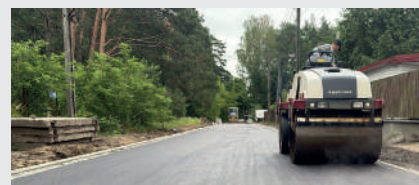
// Prace na ul. Wypoczynkowej (od ul. Wspaniałej w kierunku Świdra)
