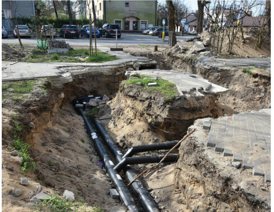
// Nowe rury sieci ciepłowniczej w centrum Otwocka przy ul. Hożej.
