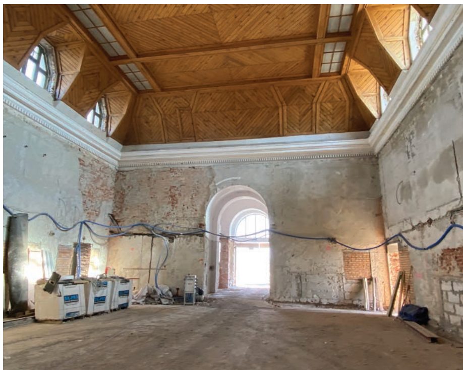
// Wnętrze zabytkowego dworca przejdzie gruntowną modernizację z zachowaniem historycznego stylu.
