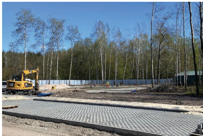
// Powstanie ponad 140 miejsc parkingowych.
