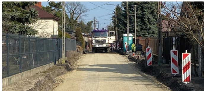
// Prace na ul. Topolowej.
