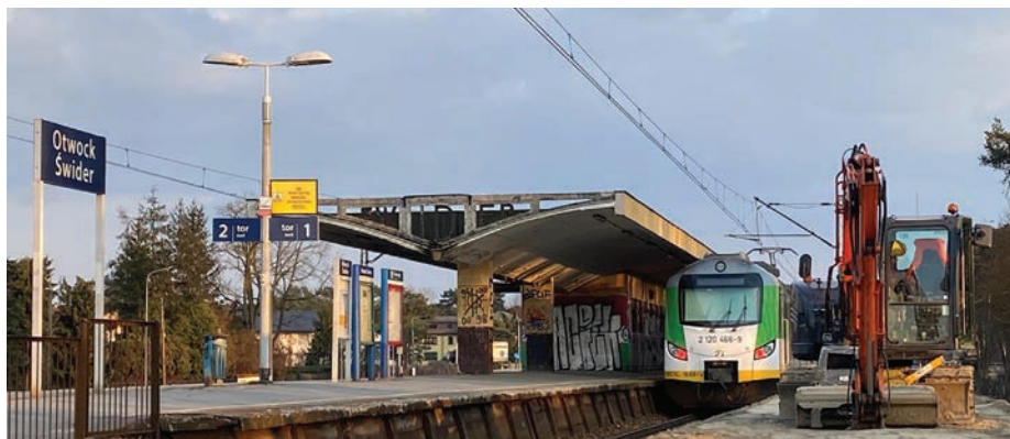
// Stacja PKP w Otwocku-Świdrze rozpoczęcie prac.
