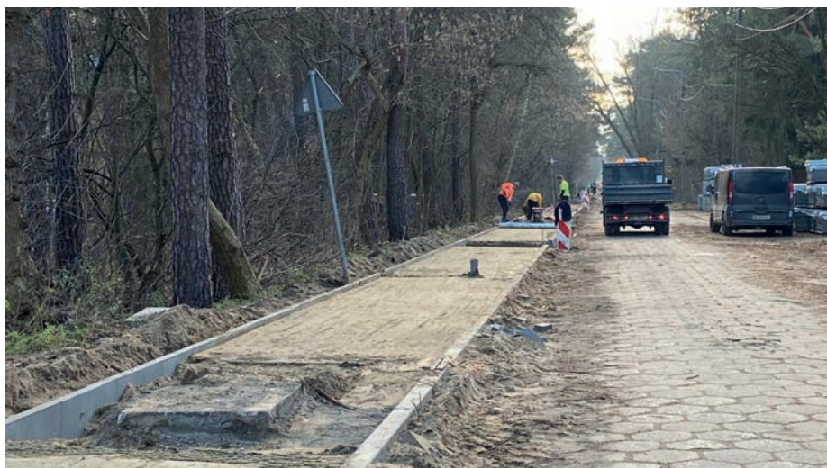
// Budowa nowego chodnika w ul. Piłsudskiego – stan prac połowa grudnia 2025 r.
