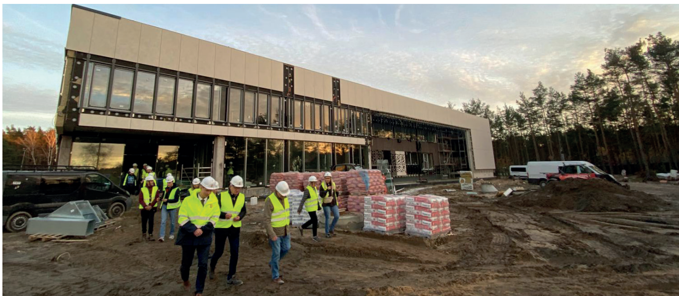
// Prezydent i radni podczas wizyty na budowie basenu w listopadzie 2025 r.
