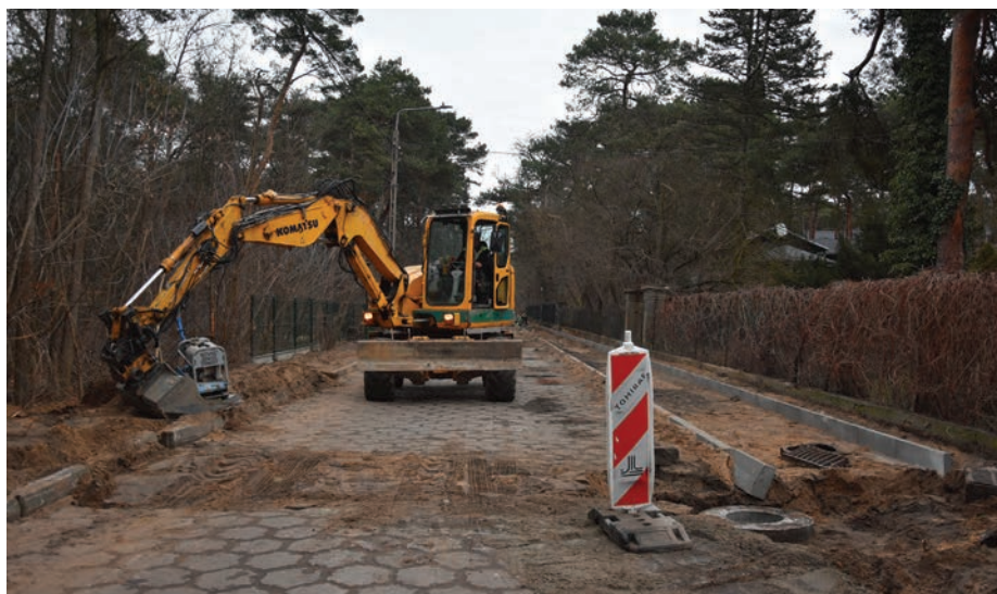
// Ulica Piłsudskiego w trakcie remontu – stan prac połowa grudnia 2025 r.
