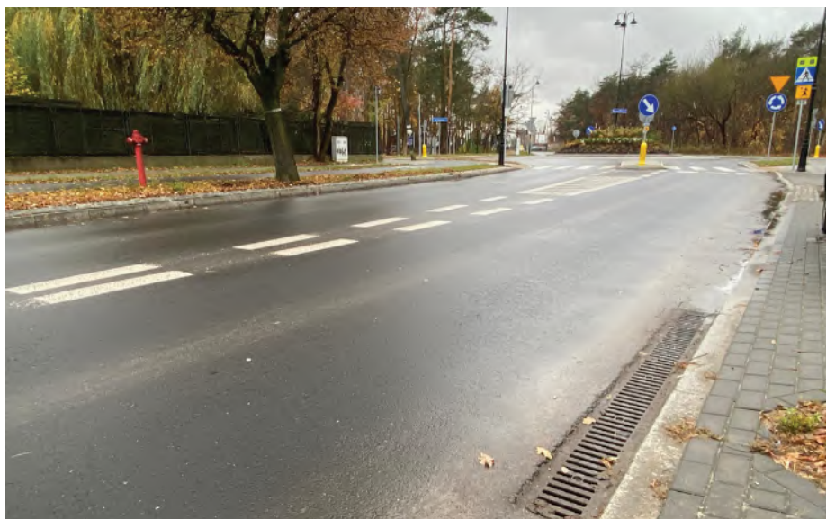
// Zlikwidowane rozlewisko na ul. Wawerskiej.
