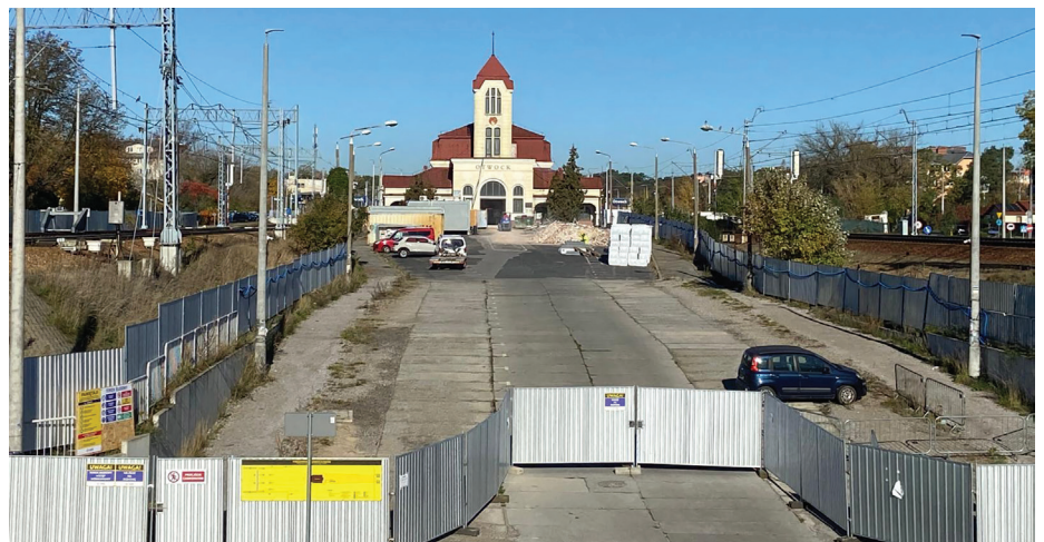
// Teren wokół dworca został wyłączony z użytkowania na czas prowadzonych prac.
