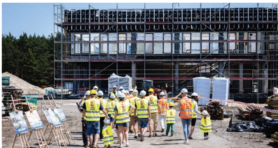
// Grupa mieszkańców na budowie kompleksu basenowego podczas dnia otwartego zorganizowanego przez miasto i wykonawcę.
