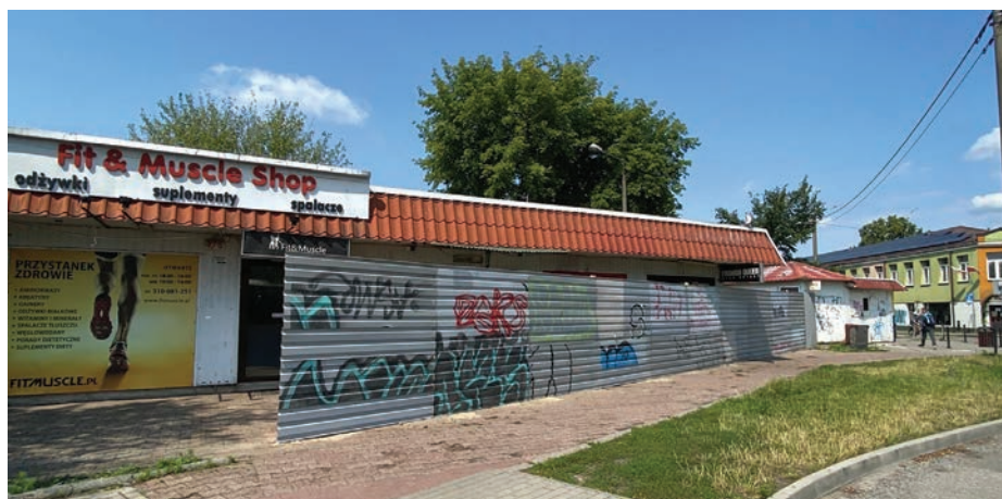
//Bazarek przy ul. Orlej już niebawem zamieni się w plac budowy, teren zostanie ogrodzony.
