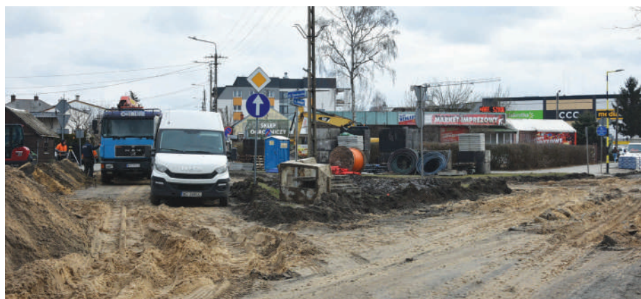
// Miejsce budowy jednego z rond.
