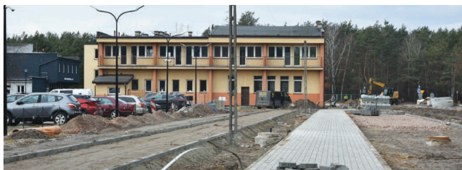
// Budowa nowego chodnika, ścieżki rowerowej i miejsc parkingowych wzdłuż ul. Ślusarskiego.
