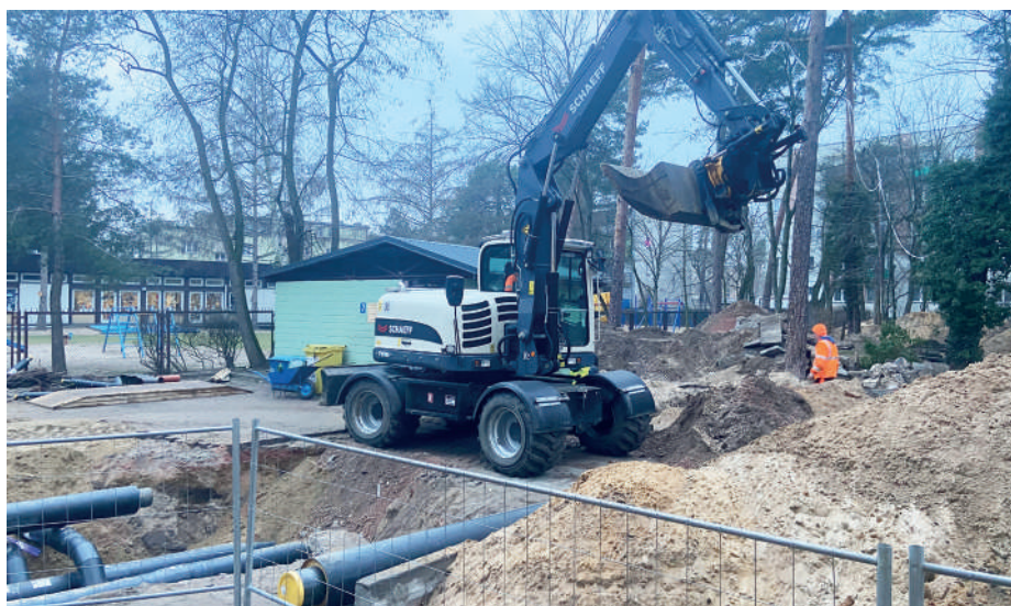
// Wymiana wyeksploatowanych rur ciepłowniczych na nowe w sąsiedztwie przedszkola nr 16.
