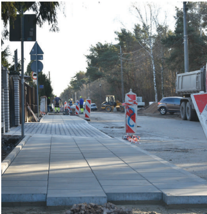
// Budowa chodnika na ul. Szkolnej.
