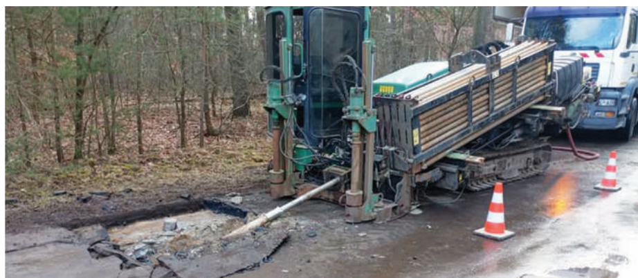
// Montaż rur kanalizacyjnych z wykorzystaniem technologii HDD.
