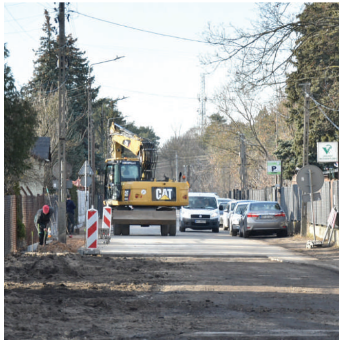
// Budowa chodnika na ul. Świderskiej.
