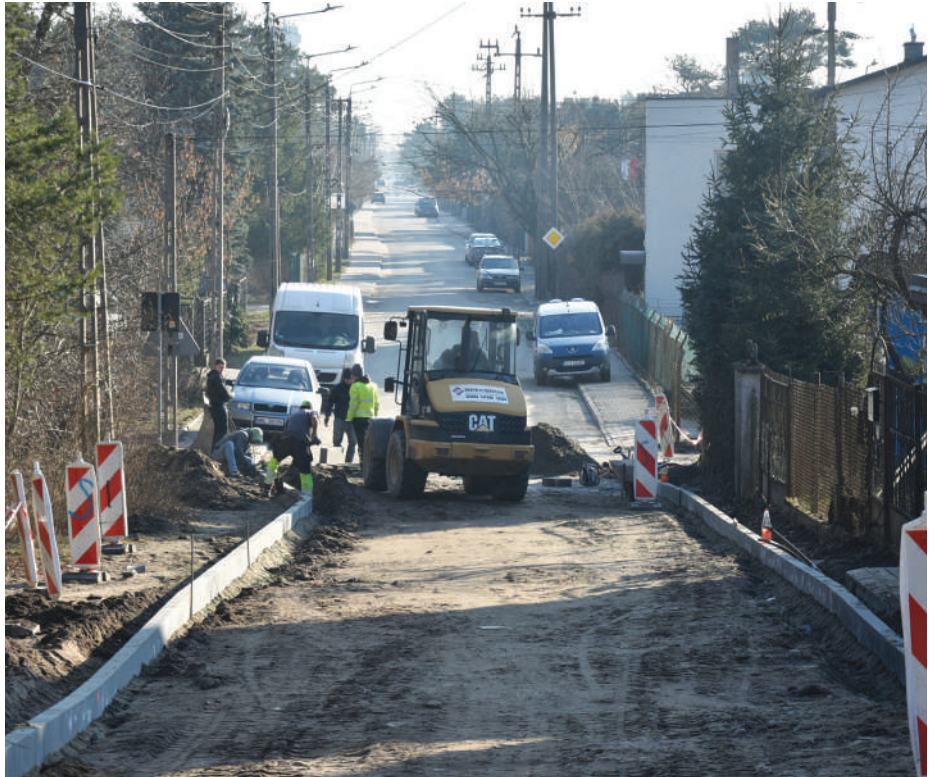
// Budowa nawierzchni asfaltowej na brakującym odcinku ul. Okrzei do ul. Marusarzówny.
