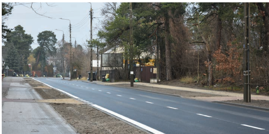
// Ulica Kraszewskiego po przebudowie, z chłonnym i docelowo zielonym poboczem.
