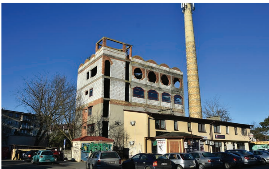
// Niedokończona inwestycja przy ul. Sportowej niebawem może zniknąć z krajobrazu Otwocka.
