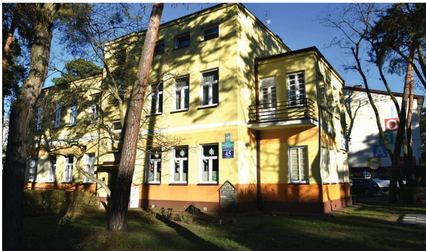
// Centrala Miejskiej Biblioteki Publicznej zajmuje pomieszczenia na parterze w budynku przy ul. Andriollego 45.
