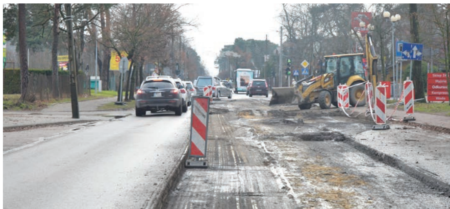
// 17 grudnia rozpoczął się remont ul. Kołłątaja realizowany przez Powiat Otwocki.
