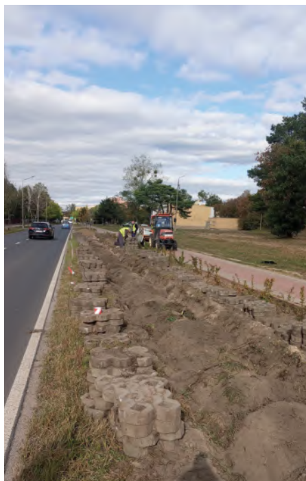
// Likwidacja rowu wzdłuż ul. Karczewskiej.
