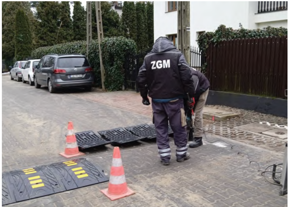
// Montaż progów zwalniających przez pracowników grupy remontowo-porządkowej ZGM.
