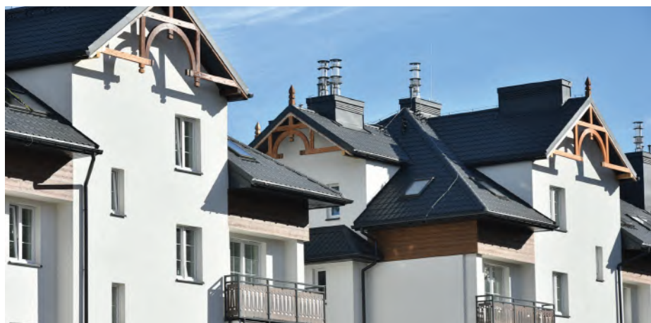
// Nowe budynki komunalne przy ul. Kochanowskiego z elementami świdermajer.
