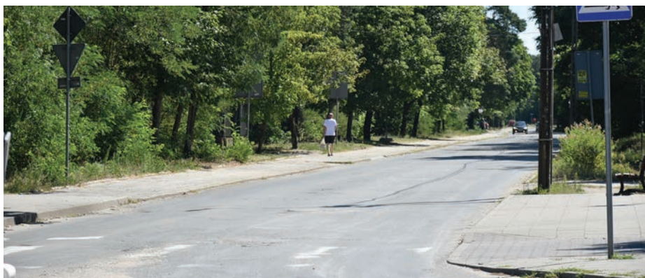
// W kolejnym etapie zostanie przebudowana ul. Reymonta do ul. Tatrzańskiej.
