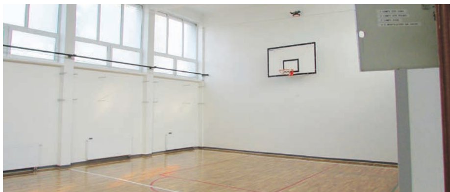
// Sala gimnastyczna po remoncie w SP nr 3.
