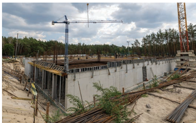
// Pomieszczenia gastronomii na poziomie - 1.
