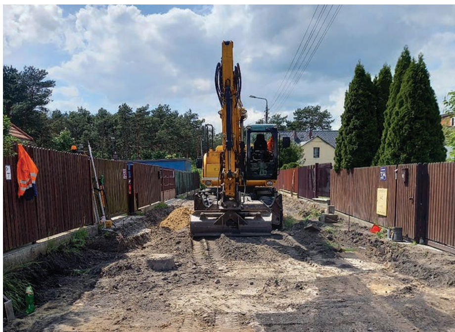
// Budowę 77 odcinków ulic zrealizuje dwóch wykonawców.
