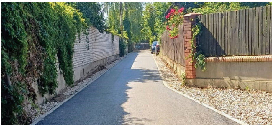
// Ulica Bajkowa z nawierzchnią asfaltową
