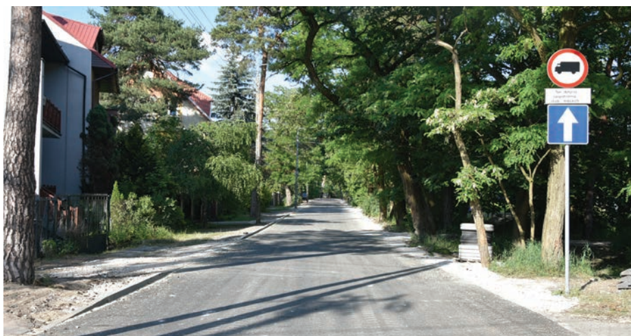
// Ulica Willowa z nawierzchnią asfaltową
