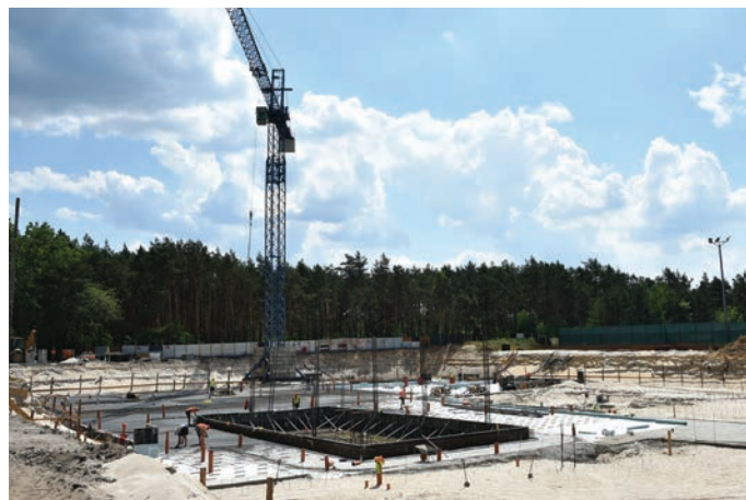
// Plac budowy kompleksu basenowego przy ul. Karczewskiej
