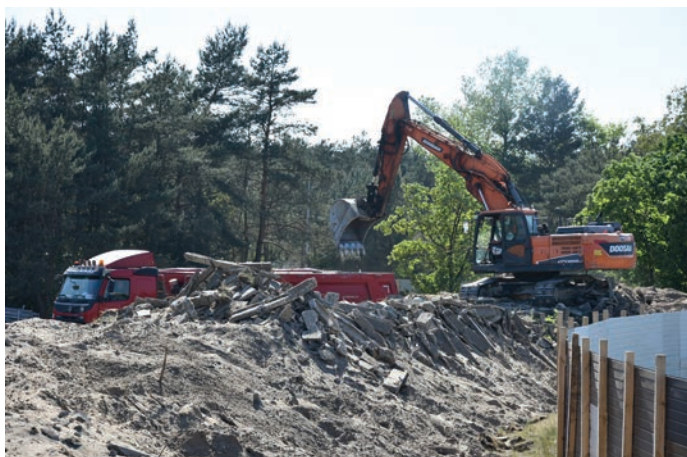
// Rozbiórka łuku trybuny od strony basenu
