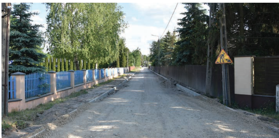
// Ulica Nowa w trakcie budowy
