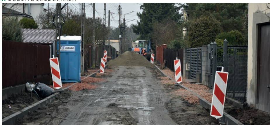
// Prace na ul. Lachowicza
