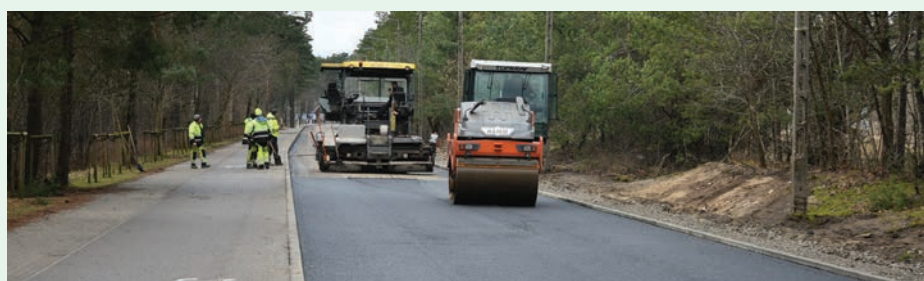
// Prace na ul. Armii Krajowej na odcinku od ul. Narutowicza do ul. Pułaskiego
