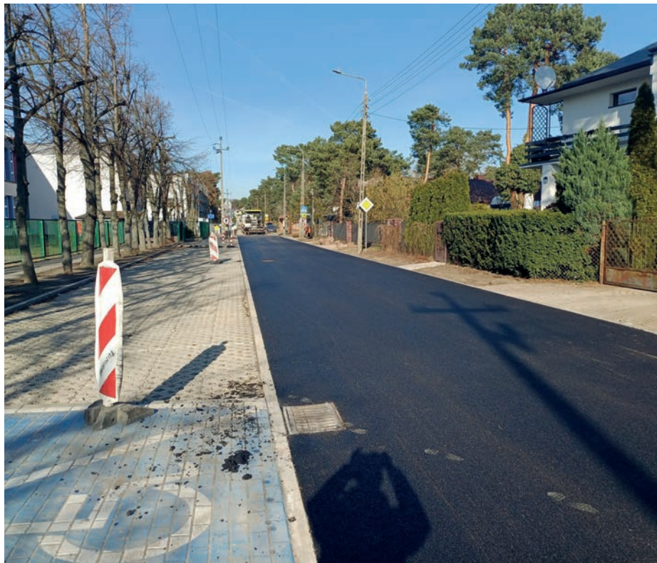
// Nowa nawierzchnia asfaltowa na ul. Tysiąclecia przy SP nr 6
