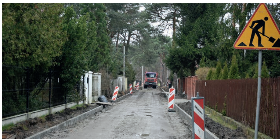
// Budowa ul. Sputników
