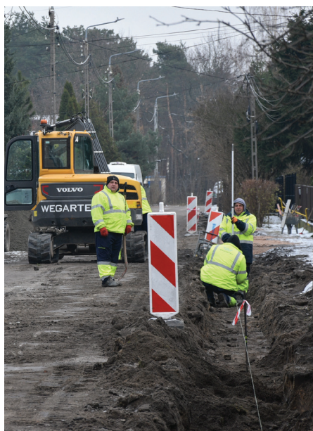
// Prace na ul. Mazurskiej
